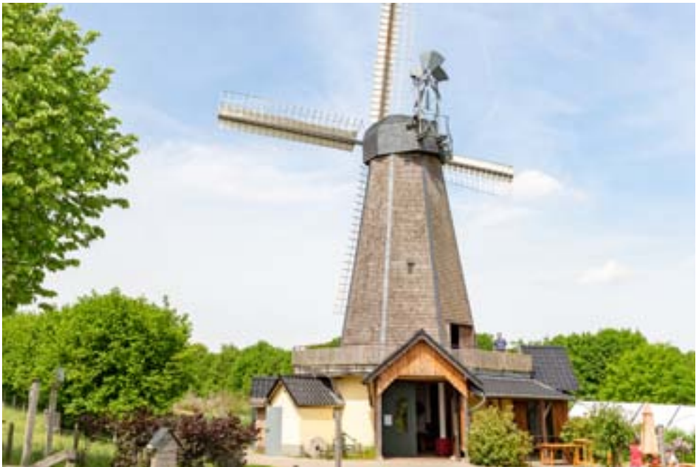
Glessener Mühlenhof, Bergheim
